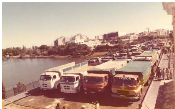
Arriba dcha. y abajo izda.: Camiones sobre el tablero del puente para la prueba de carga.
