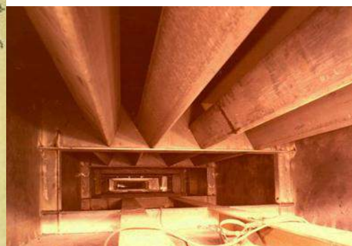
↑ Viga y nervios de la chapa ortótropa.
